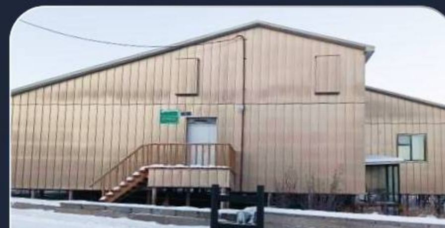
БОЛЬНИЦА С. УСТЬ-БЕЛАЯ (КАПИТАЛЬНЫЙ РЕМОНТ)
