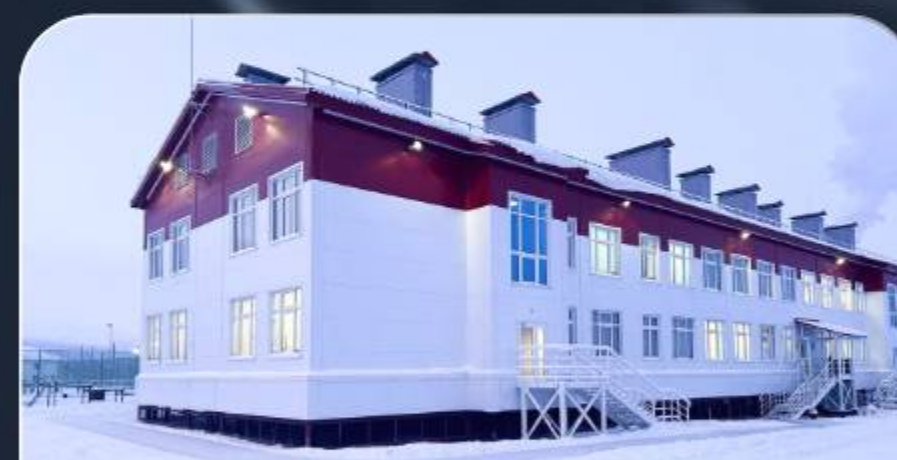
НОВАЯ ШКОЛА НА 100 МЕСТ В С. ОСТРОВНОЕ БИЛИБИНСКОГО МР
